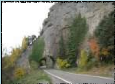
CARRETERAS METIDAS EN ENTORNOS CASI INACCESIBLES. Las carreteras que transitan por el Pirineo Aragonés son, en ocasiones, auténticas epopeyas de la ingeniería de la época, como se puede apreciar en la Foz de Binies.
